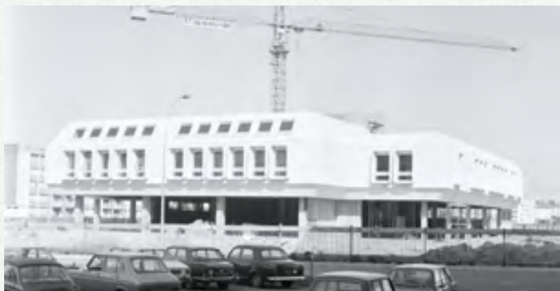
Travaux d'aménagement du nouvel hôtel de ville, avant son inauguration le 21 juin 1975.
