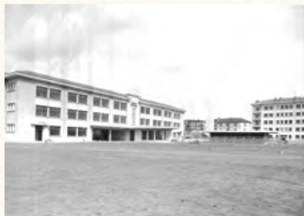
L'école de la gare lors de sa construction en 1953.
